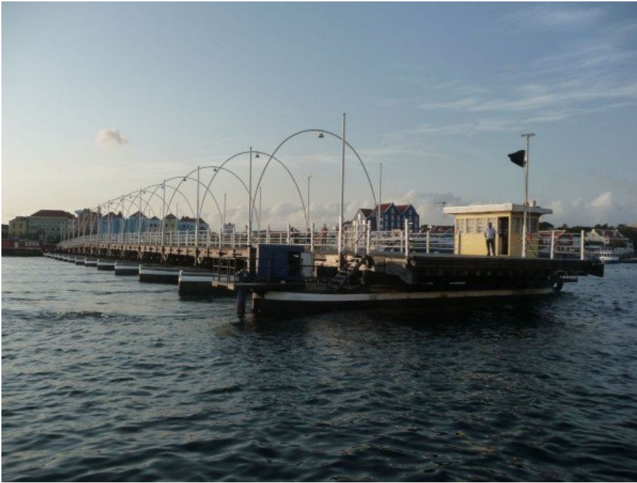
Ponte flutuante Queen Emma.
